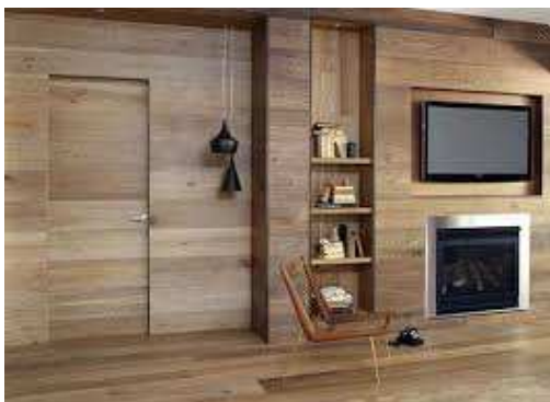
RIVESTIMENTO INTERNO DI LEGNO
