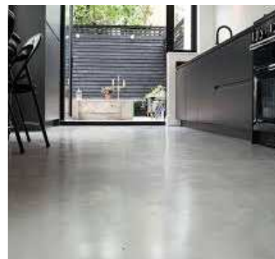
PAVIMENTO IN CEMENTO
