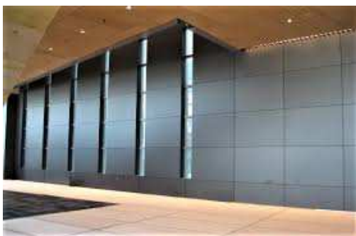
RIVESTIMENTO METALLICO INTERNO
